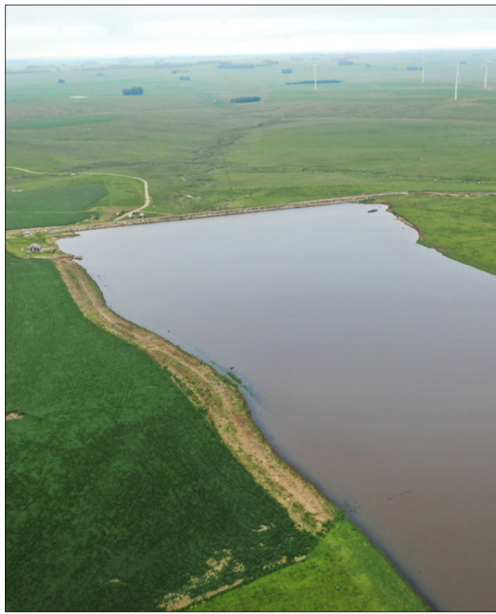
Eine «Represa» mit künstlich angestautem Regenwasser. Damit werden Trockenzeiten überbrückt. (Bilder Thomas Siegenthaler)
