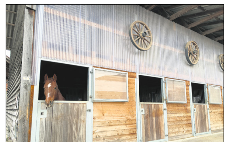
20 Pferdeboxen sind aus den umliegenden Gebäuden und dem alten Mastmunistall entstanden. (Bilder sjh)
