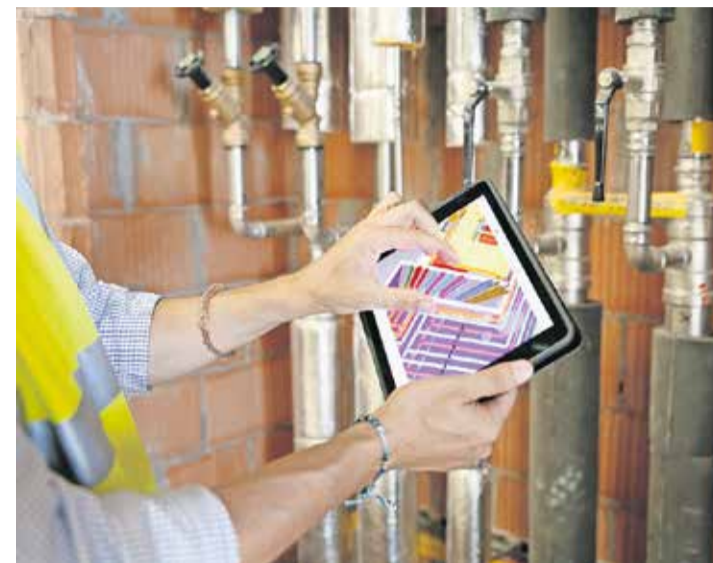
Auf dem Tablet ist jede Leitung über ihre Farbe erkennbar. Bild mg
